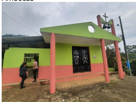
Fotografía 24. Iglesia en el Barrio Ambocas
